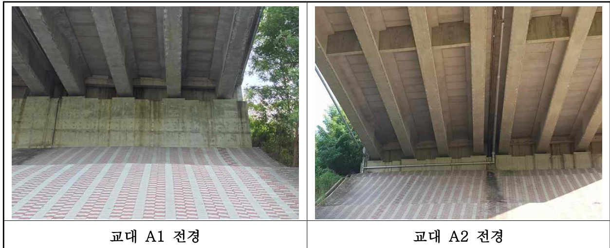
【사진 14.3.8】 교대 전경
