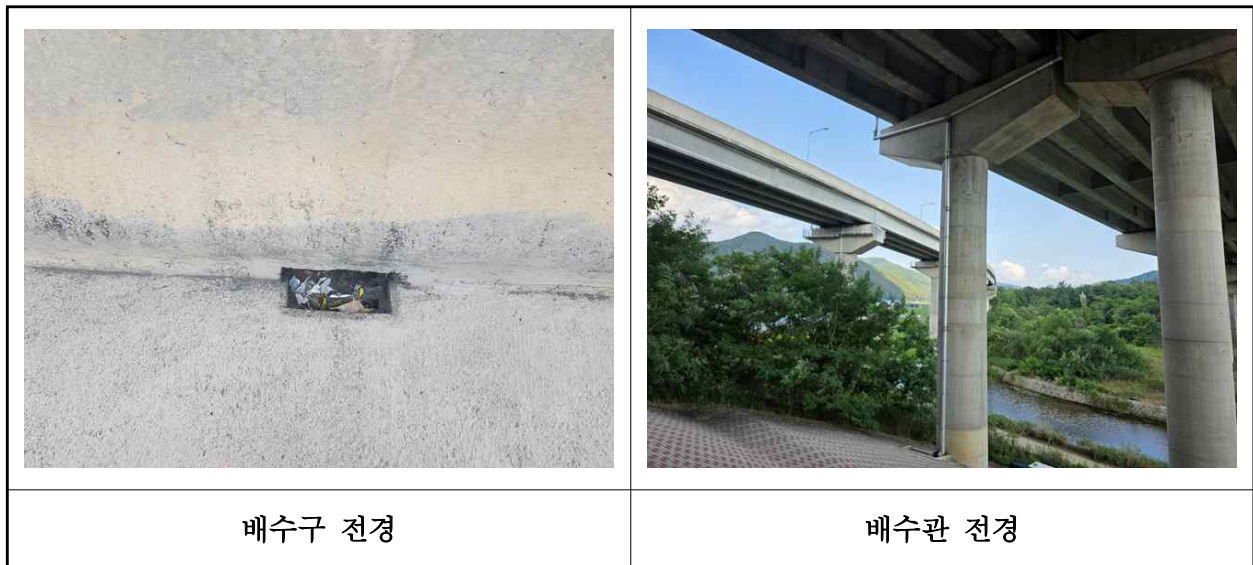
【사진 14.3.22】 배수시설 전경
