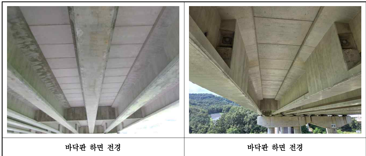
【사진 14.3.27】 바닥판하면 전경
