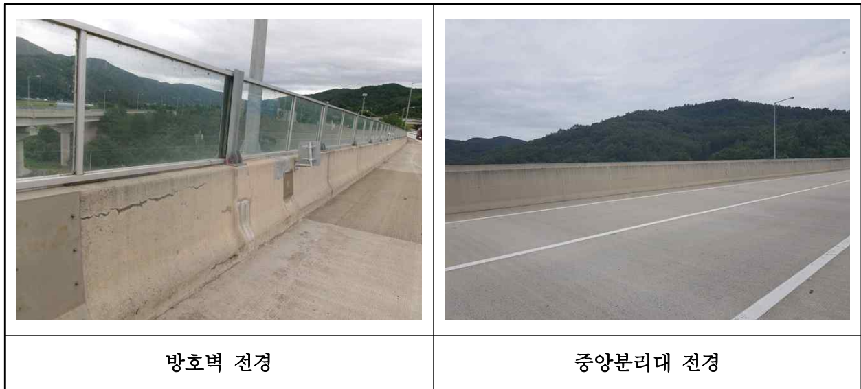
【사진 14.3.24】 방호벽 및 중앙분리대 전경
