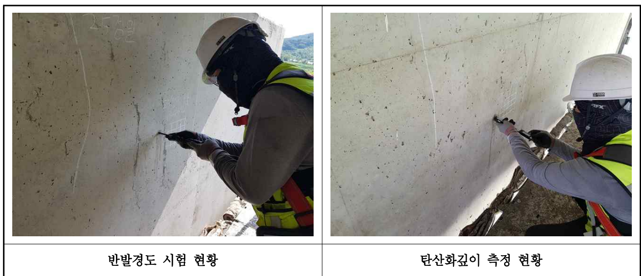
【사진 14.4.1】 콘크리트 내구성조사 현황
