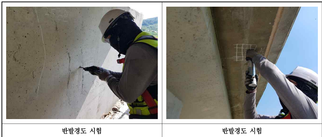
【사진 14.4.2】 반발경도시험 현장사진
