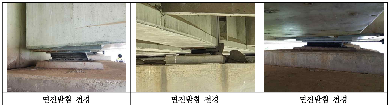
【사진 14.3.13】 교량받침 전경
