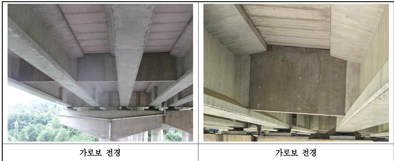
【사진 14.3.6】 가로보 전경
