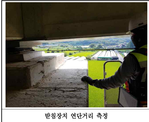
【사진 14.3.40】 교량받침장치 연단거리측정
