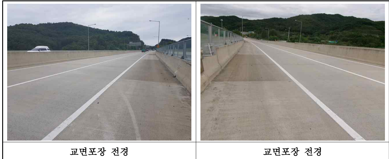
【사진 14.3.20】 교면포장 전경
