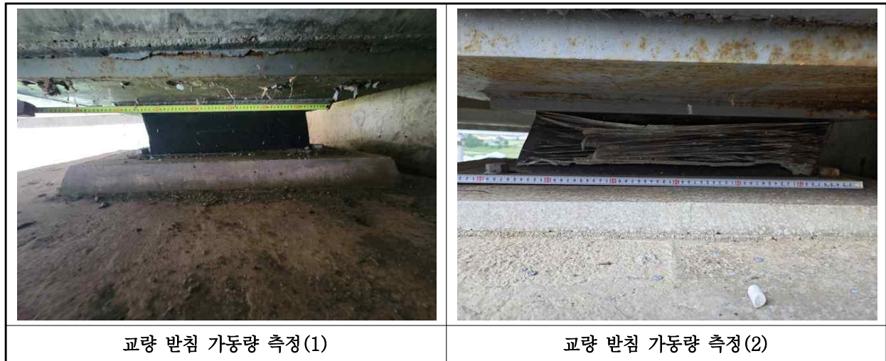
【사진 14.3.41】 교량받침 이동량 측정
