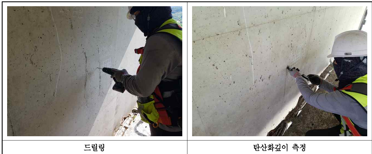
【사진 14.4.3】 탄산화 깊이 측정 현장사진
