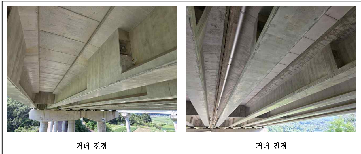
【사진 14.3.29】 거더 전경
