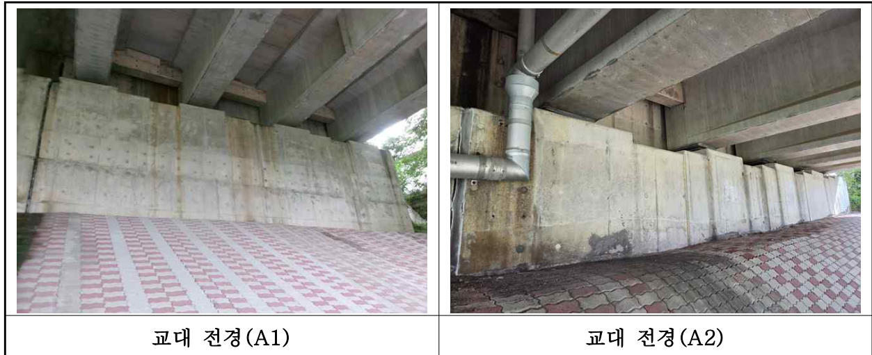
【사진 14.3.33】 교대 전경
