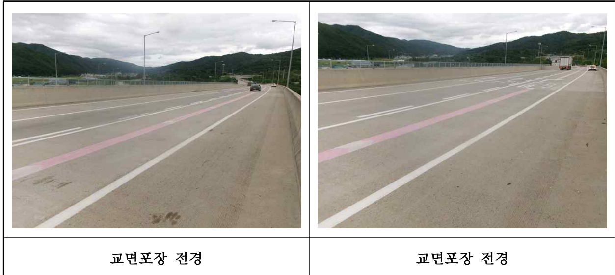
【사진 14.3.45】 교면포장 전경
