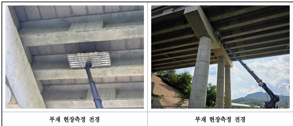
【사진 14.2.1】 부재 현장측정 전경
