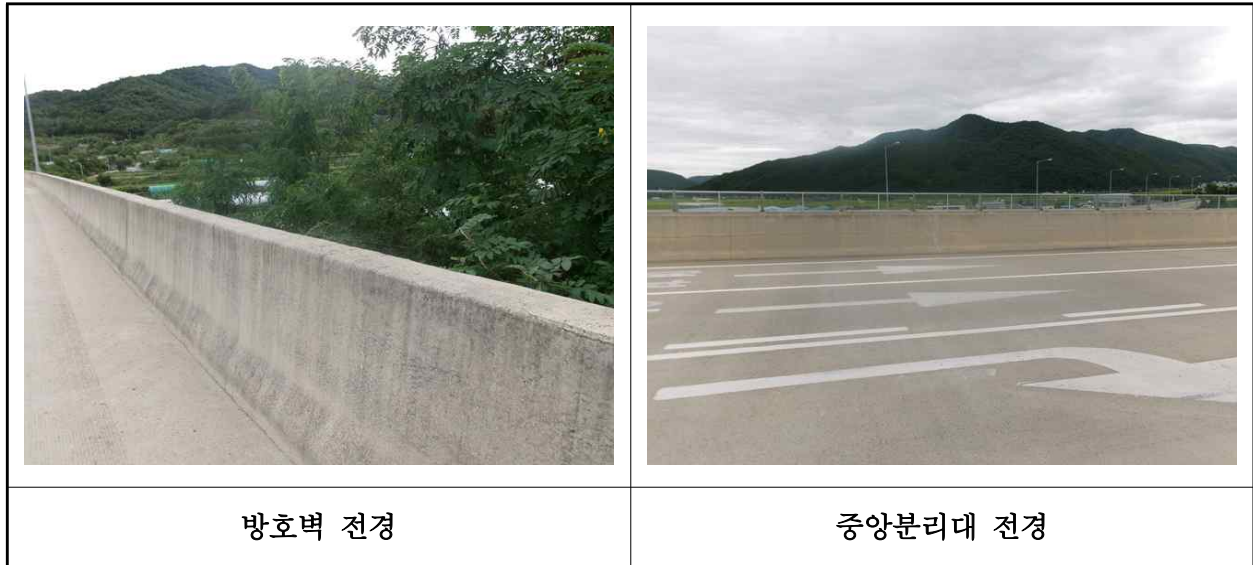
【사진 14.3.49】 방호벽 및 중양분리대 전경
