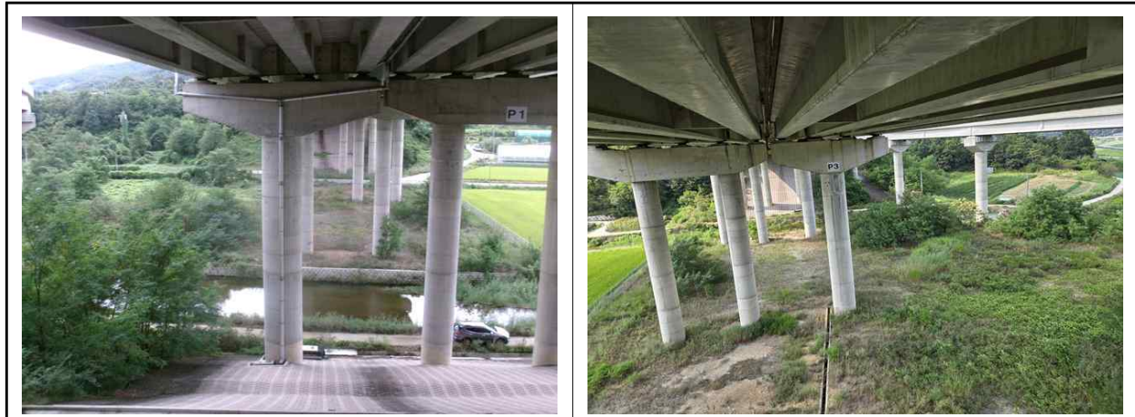
교각 코핑부 상태양호
