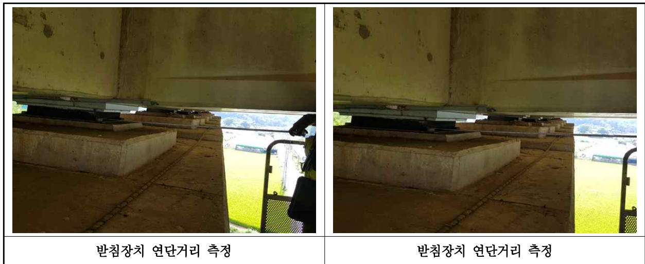
【사진 14.3.15】 교량반침장치 연단거리측정
