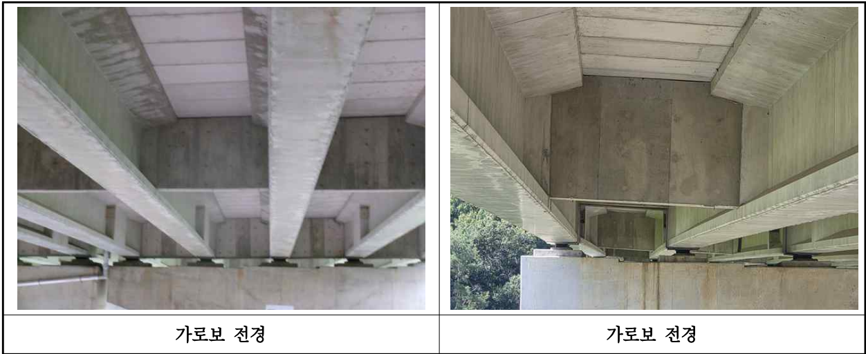
【사진 14.3.31】 가로보 전경
