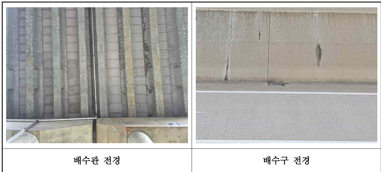
【사진 14.3.47】 배수시설 전경
