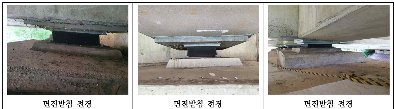
【사진 14.3.38】 교량받침 전경
