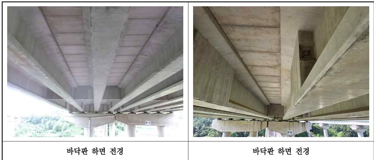
【사진 14.3.2】 바닥판하면 전경
